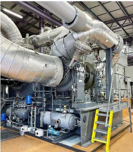
Eine Turbokompressor-Wärmepumpe von Atlas Copco Gas and Process. Sie unterstützt das Fernwärmenetz von Stockholm.
