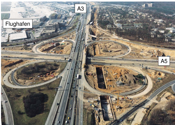
Bild 22. Autobahnkreuz Frankfurt – Knotenpunkt von A3 und A5 am Frankfurter Flughafen
