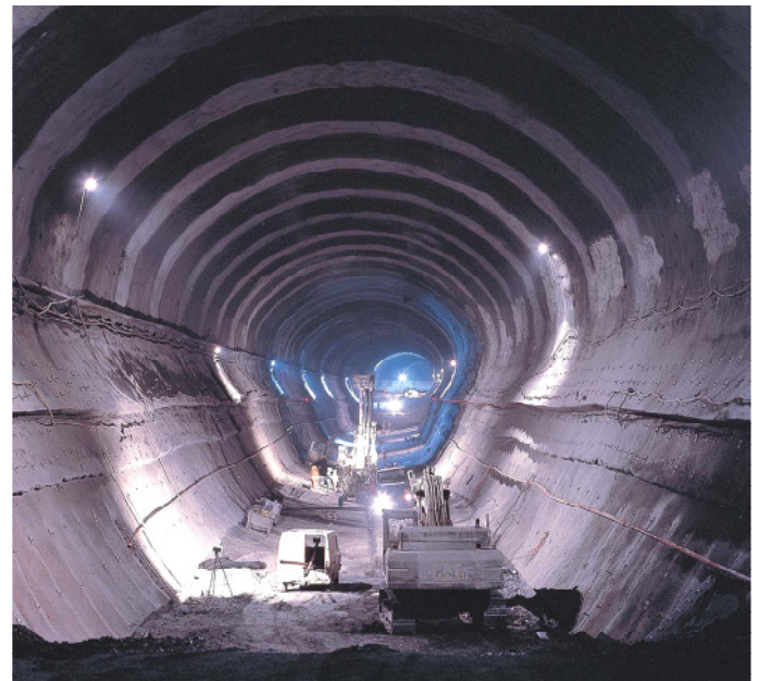
Bild 10. Bodenaustausch im Bereich des Anhydrits (Hering & Walliser 1998)
