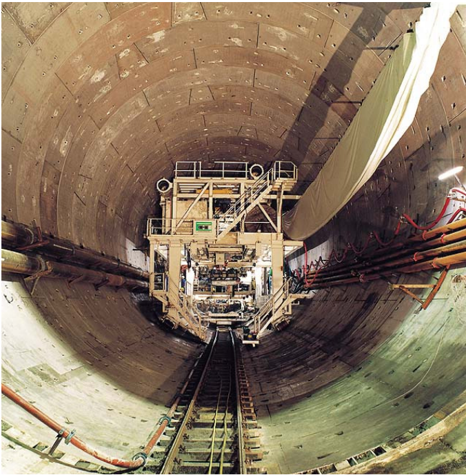
Bild 36. Tübbingringausbau (Lohrmann & Miemietz 2002)
