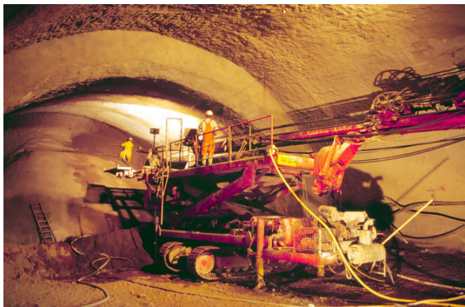
Bild 29. Herstellung des HDI-Schirms
