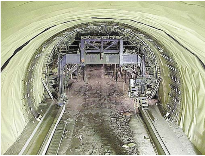
Bild 5. Einbau der Innenschale (Prax et al. 2000)
