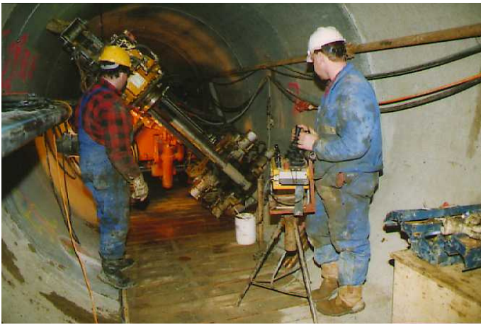
Bild 18. Brunnenherstellung aus Pilotstollen (Sänger 2000)
