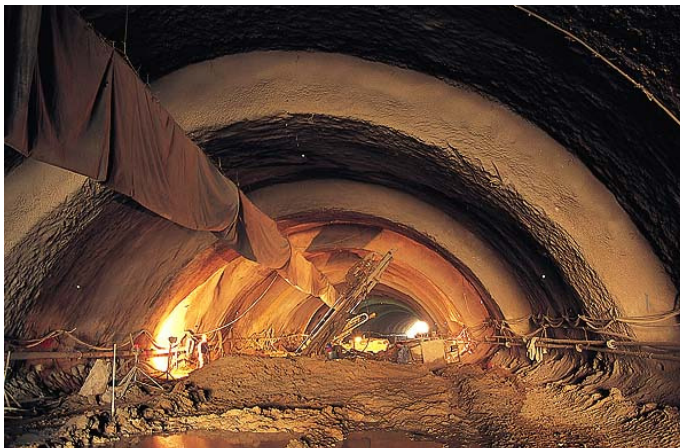
Bild 30. Ausbruch der Kalotte im Schutz des HDI-Schirms (Hofmeister & Roth 1999)
