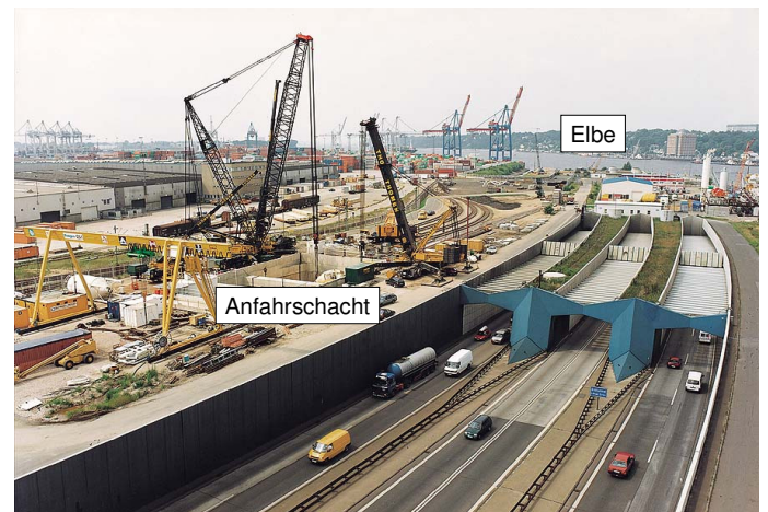
Bild 31. Bau der 4. Elbtunnelröhre westlich des bestehenden Tunnels (Lohrmann & Miemietz 2002)
