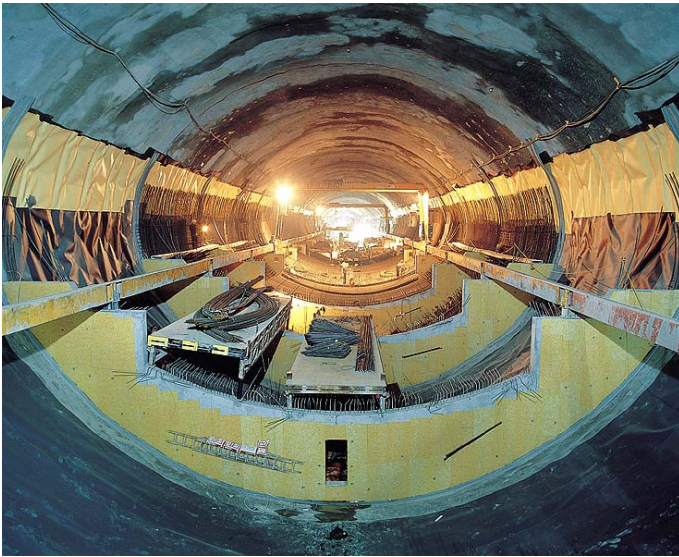
Bild 12. Herstellung des Sohlgewölbes (Hering & Walliser 1998)
