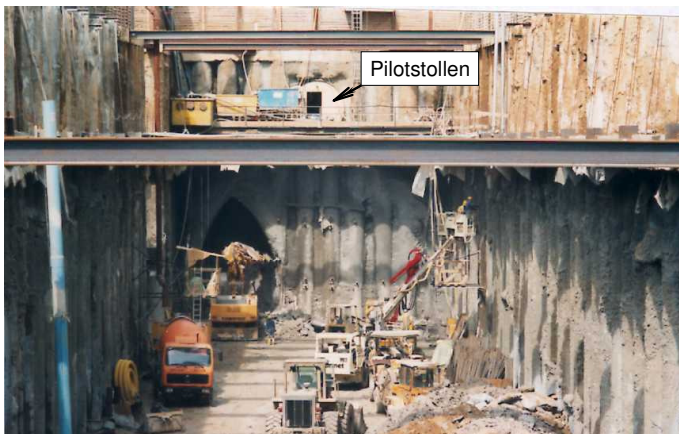
Bild 19. Tunnelanschlagwand "Süd"
