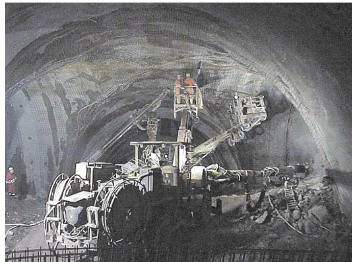
Bild 4. Einbau von Zusatzbewehrung, LAZ Kehlthal (Prax et al. 2000)
